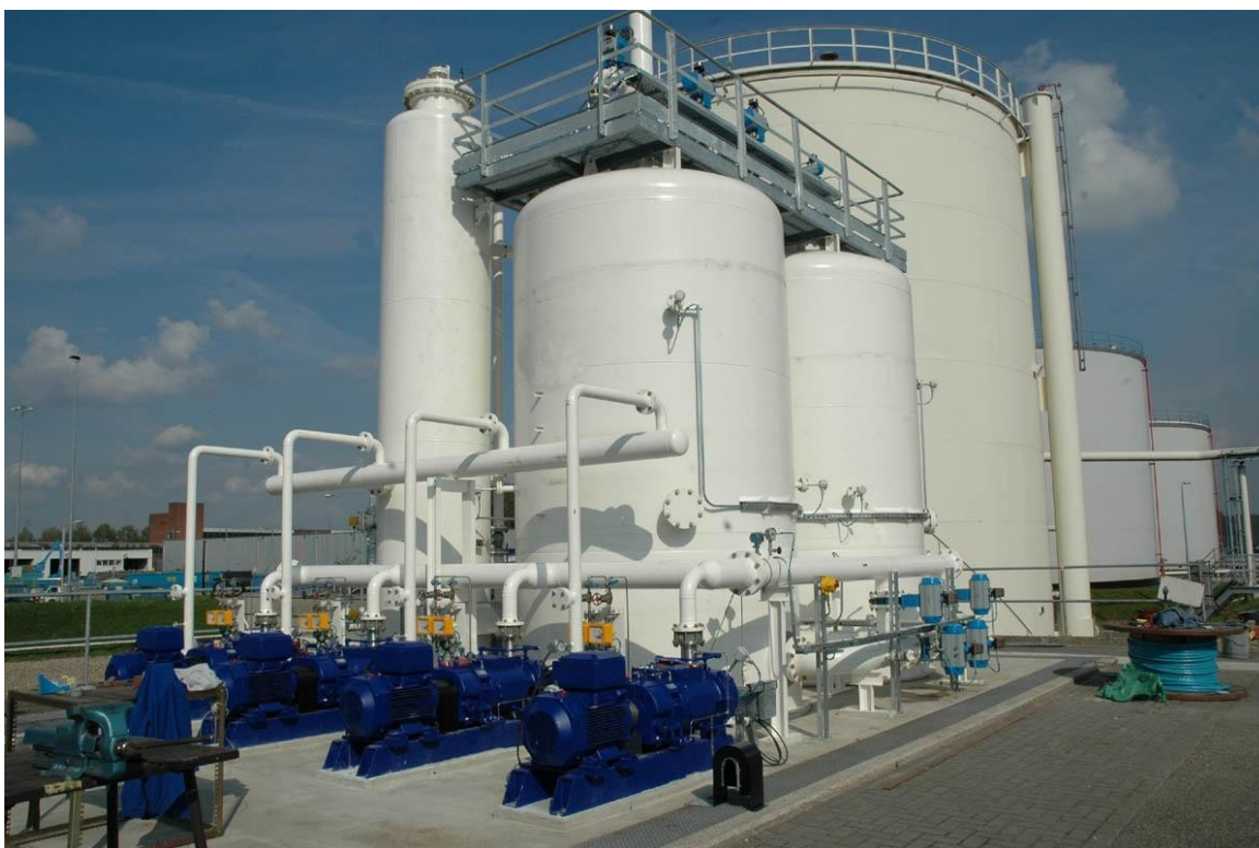
Система Рекуперации Паров, установленная на автомобильном терминале компании Shell в Археме, Голландия.
